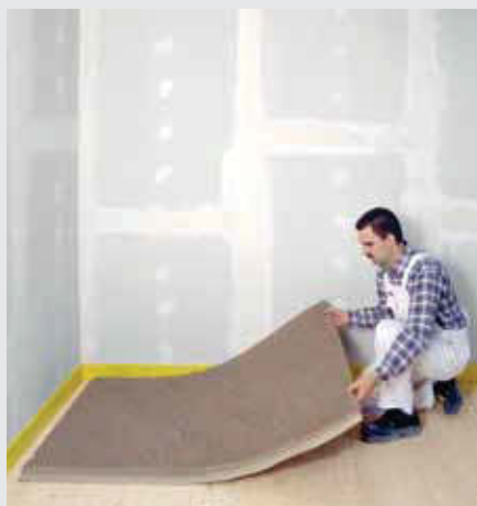
Pokládání podlahové voštiny fermacell
