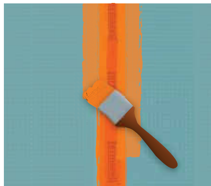
Těsnící páska fermacell se vtlačí do nanesené, ale ještě vlhké tekuté fólie fermacell a ihned se tekutou fólií přetře, doba schnutí: min. 1 hodina
