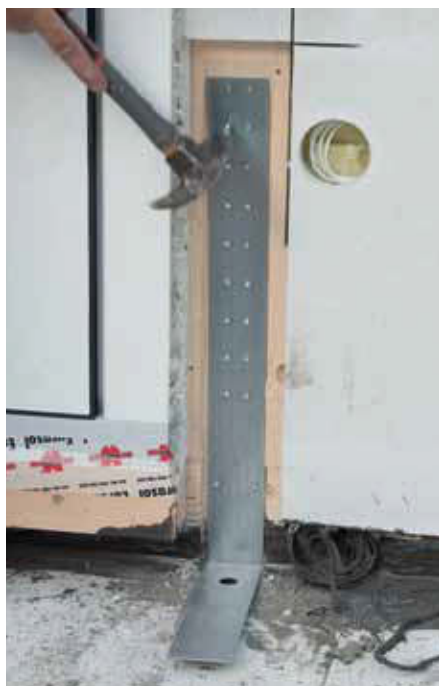
Montáž tahové kotvy (kotevní deska není ještě osazena)
