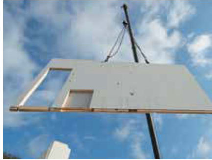
Staveništní doprava jeřábem
