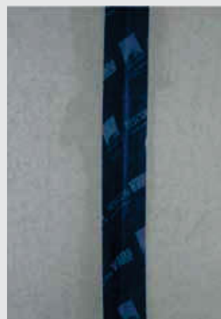
Vzduchotěsné prolepení vnitřního rohu desek fermacell Vapor
