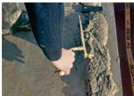
Nanášení maltového lože
