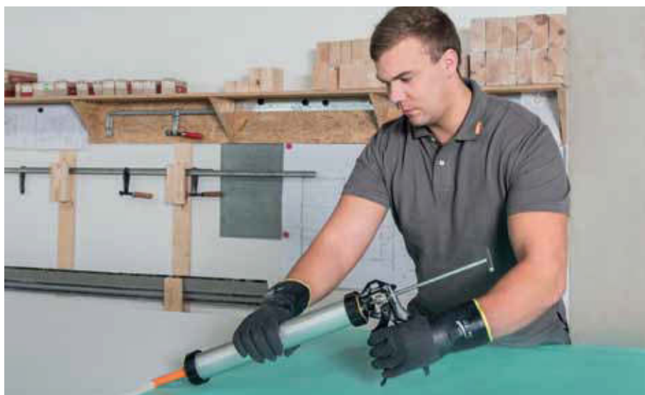
Nanášení spárovacího lepidla fermacell z praktického 580 ml balení ve folii
