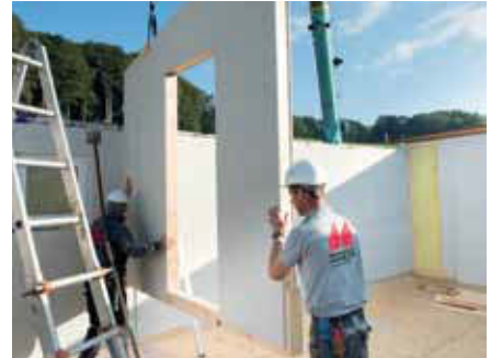
Montáž na staveništi
