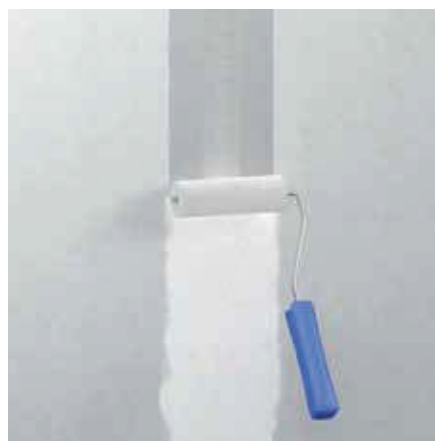
Nanesení armovacího lepidla fermacell HD válečkem
