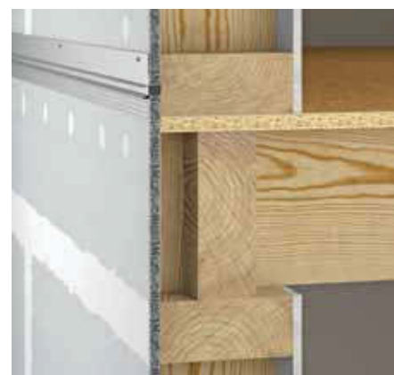
Obr. 6: Hotová montáž pruhu desky se styčným stropním profilem fermacell
