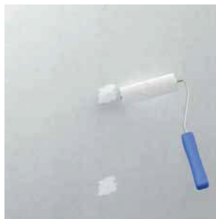
Krycí nanesení lepidla na spojovací prostředky ve středu desky
