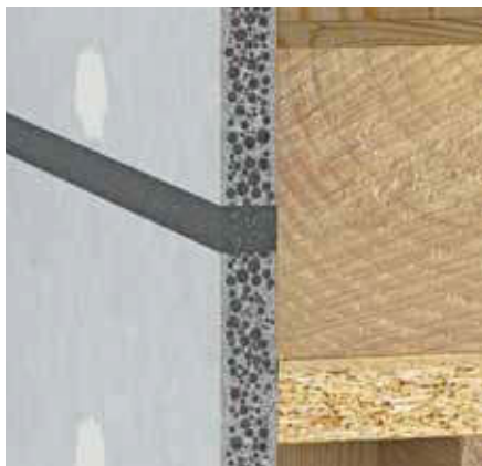
Obr. 4: Uzavření spáry předkomprimovaným těsnícím pásem (detail)
