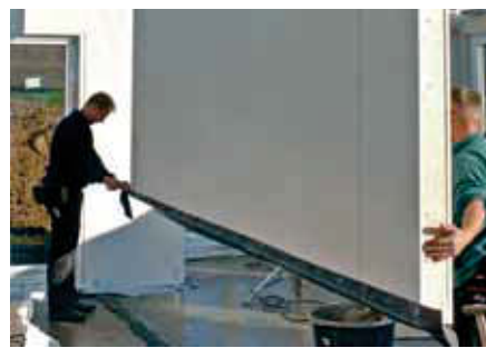
Osazení stěnového panelu do maltového lože
