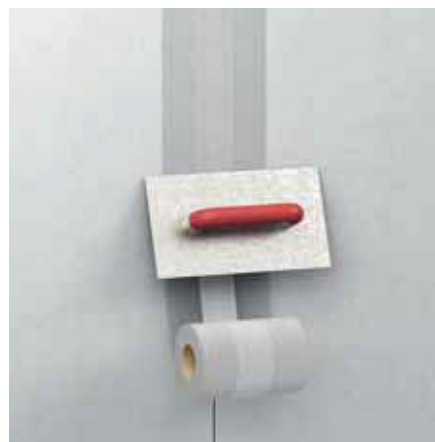
Nanesení armovacího pásky fermacell HD
