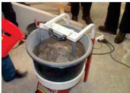
Míchání výplňové malty fermacell
