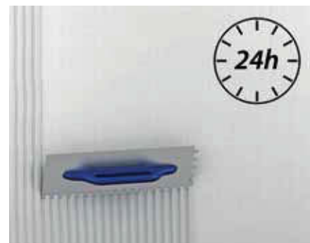
Nanesení druhé vrstvy lehké malty fermacell v tl. 2 - 3 mm po vytvrzení armovací vrstvy (varianta A)
